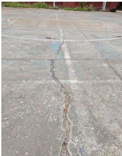
**Imagem 04 e 05** - Piso da quadra já existente, deteriorado.
